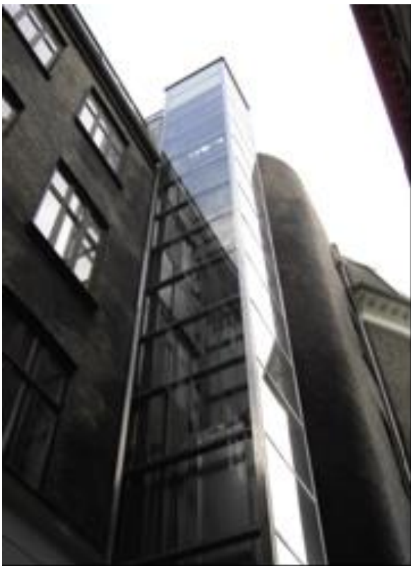
Udvendig elevator i nr. 6B. Foto: sbs
