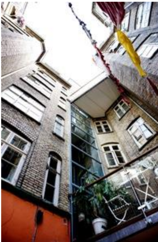
Placeret hvor køkkentrappen tidligere var.
