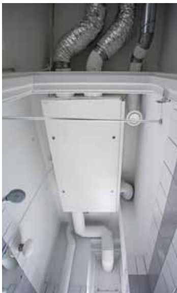
I en prøvelejlighed er ventilationsløsningen fuldt monteret. Til venstre ses overgangen fra vådrummet til fordelingsgangen, hvor det nedsænkede loft er blottet. Til højre ses hvordan stukken er blevet skånet
