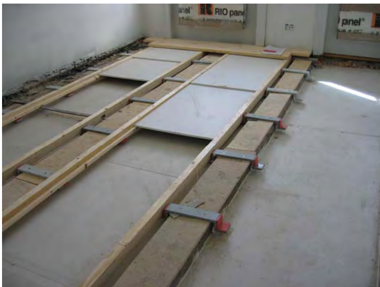
Der er monteret hatteprofiler og udlagt gips mv. mellem de eksisterende bjælker.
