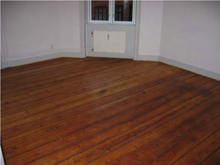
Eksempel på et rum, hvor der ikke er udført nogen lydisolationsforbedrende arbejder
