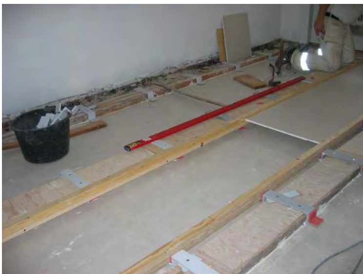
Særlig tilslutning ved væg, hvor hatteprofilerne har en speciel udformning.
