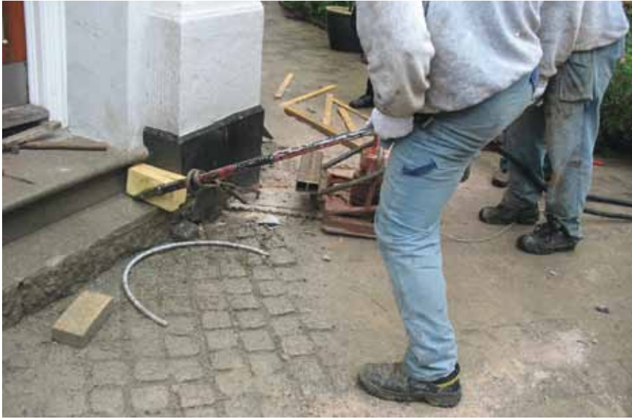
Savning af spalte med kædesav
