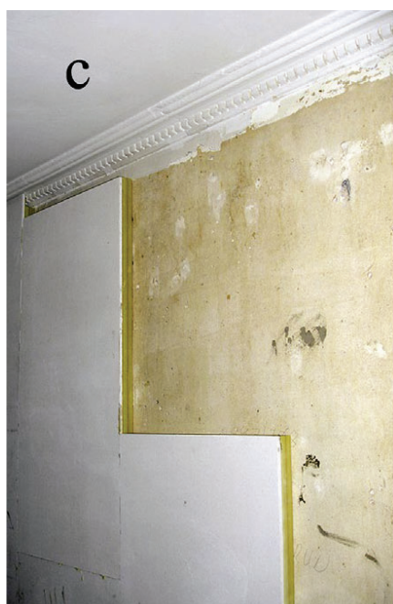
FIGUR 37. Opsætning af den indvendige efterisolering samt lodret snit af den efterisolerede facade samt placering af målepunktet i bjælkeenden. Isoleringstykkelser er 40 mm. Der er ingen isolering på de nederste 20 cm. Foto: Leif Rønby.
