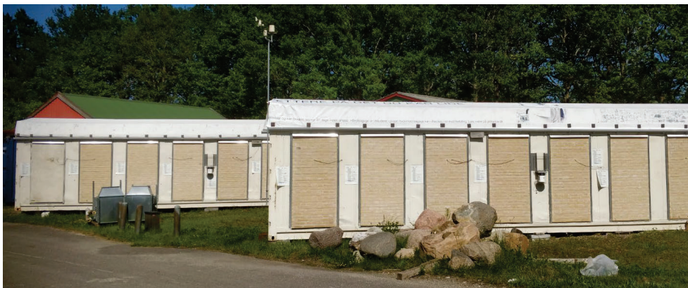
FIGUR 57. Sydvest facade af de 2 containere på DTU. Foto: Tommy Odgaard
