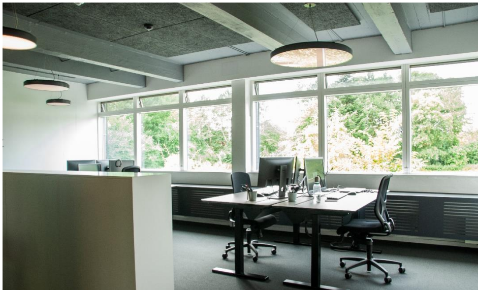
Figur E.3. Kontor med naturlig ventilation. I facaden er et højsiddende vinduesbånd med automatisk styrede åbninger. Åbningerne er jævnt fordelt i hele facaden, som sikrer at kontoret ventileres jævnt. Lokalet er uden nedhængte lofter, hvilket øger rumhøjden og den termiske masse i rummet. Optimalt havde åbningerne siddet med mindre lodret afstand til loftet, hvorved coanda-effekten kunne udnyttes mere effektivt, og dermed trække luften længere ind i lokalet. Fotokredit: WindowMaster
