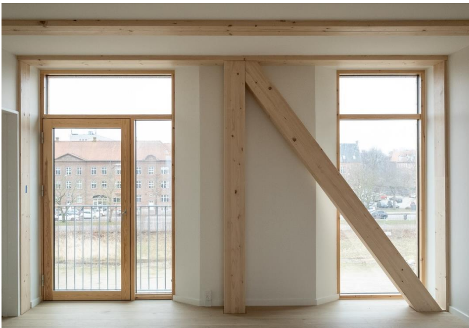
Figur 16. Let byggeri giver mulighed for skråfals som anvendt her i MiniCo2. Herved kan der optimeres på mængden af dagslys der kommer ind i boligen. Fotokredit: Realdania By & Byg / Helene Høyer Mikkelsen
