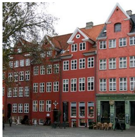
Efter yderligere to store brande, er der meget få ildebrandshuse tilbage i det indre København. Foto: Bygningskultur Danmark.
