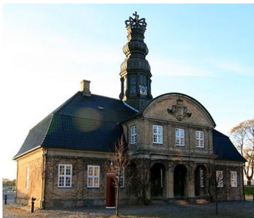
Barokken kan kendes på de svungne former og huskroppens tyngde. Foto: Bygningskultur Danmark.
