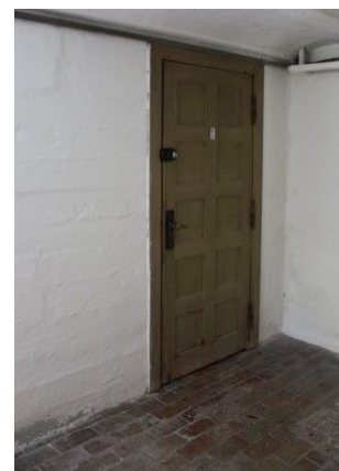
I kældre og sekundære rum var gulvet ofte beton, terrazzo, klinker eller som her tegl. Bedre Byggeskik-hus, 1929.
