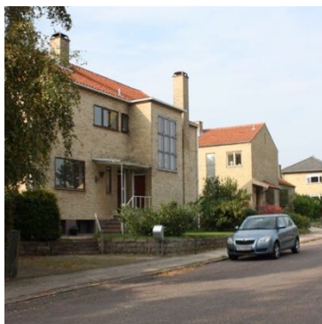
Villaer i dansk funktionalisme. Blankt murværk, tegltag og store vinduer er nogle af kendetegnene.
