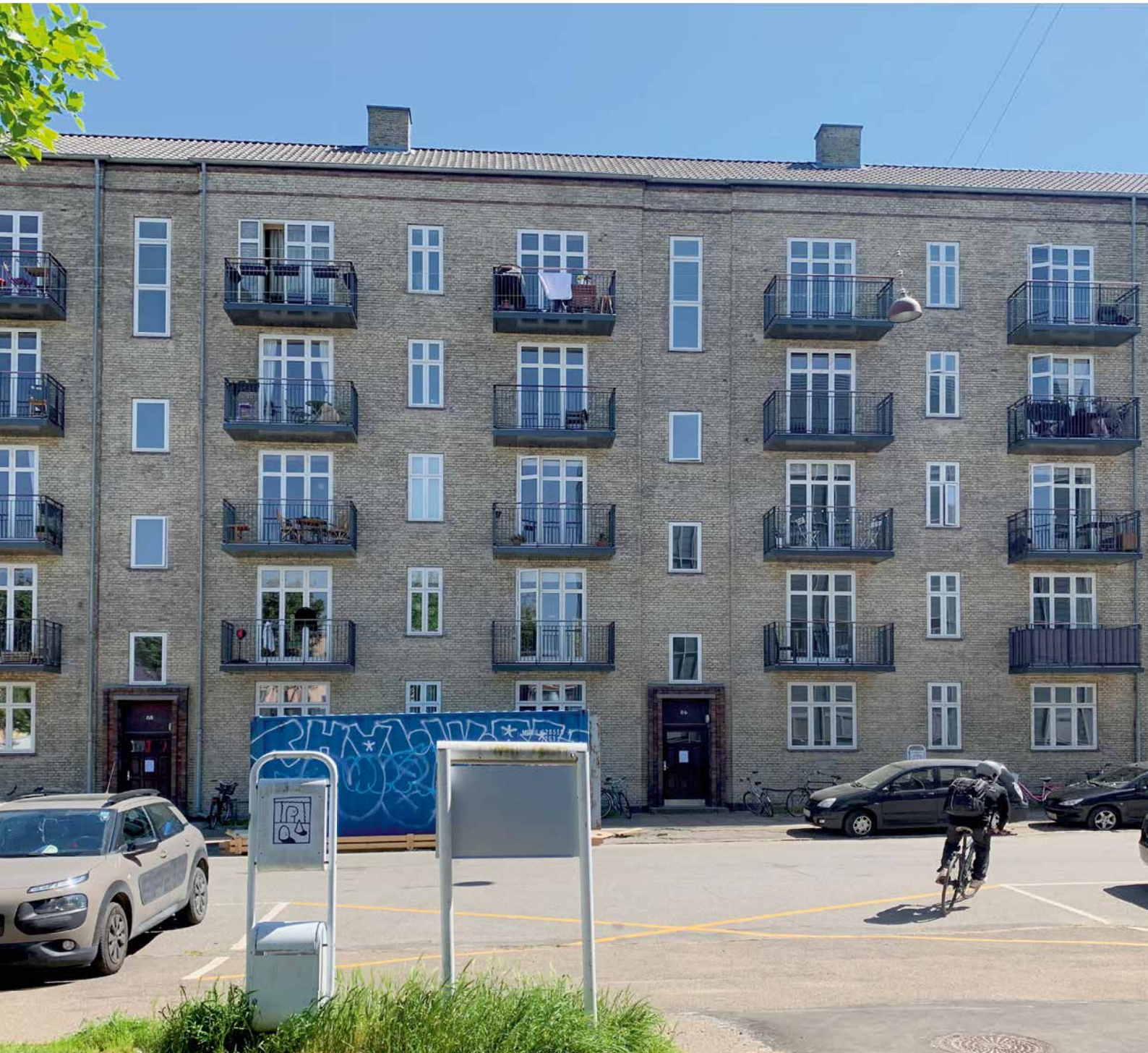
Figur 7. På Nørrebro har alle lejligheder fået opsat altaner. To af karreens facader har altaner ud mod gaden. (Foto: BUILD).
