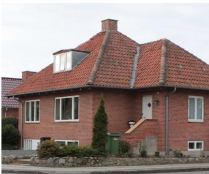
Tv: Pyramidetaget, der er en variant af et valmet tag, er afvalmet på alle fire sider. Ses ofte på funkistidens bungalower.
