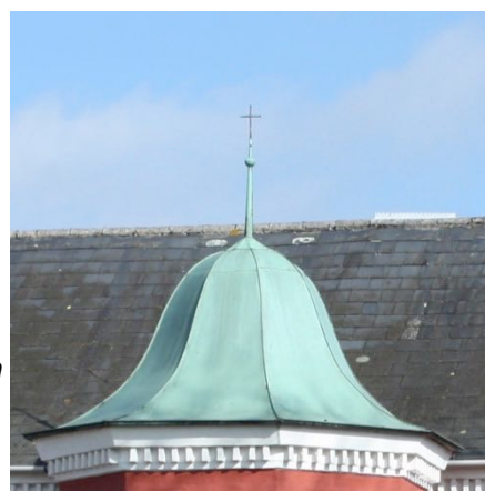
Th: Kuppeltag beklædt med kobber.
