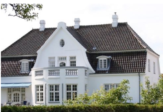
Mansardtage med sortglaserede tagsten ses både på huse i nybarok og palæstil. Det "smagte" lidt af palæer og slotte. Foto: Torben Lindegaard.
