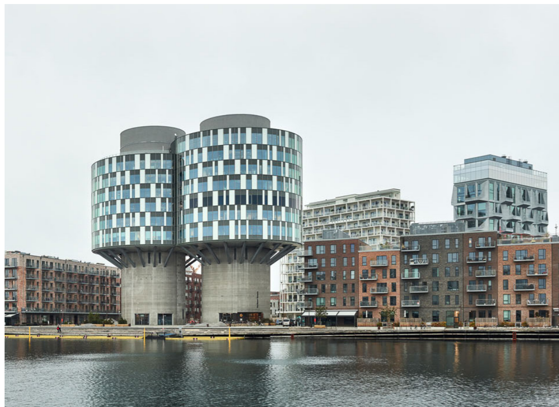
Portland Towers med de eksisterende cementkerner og de tilbyggede kontoretager.
