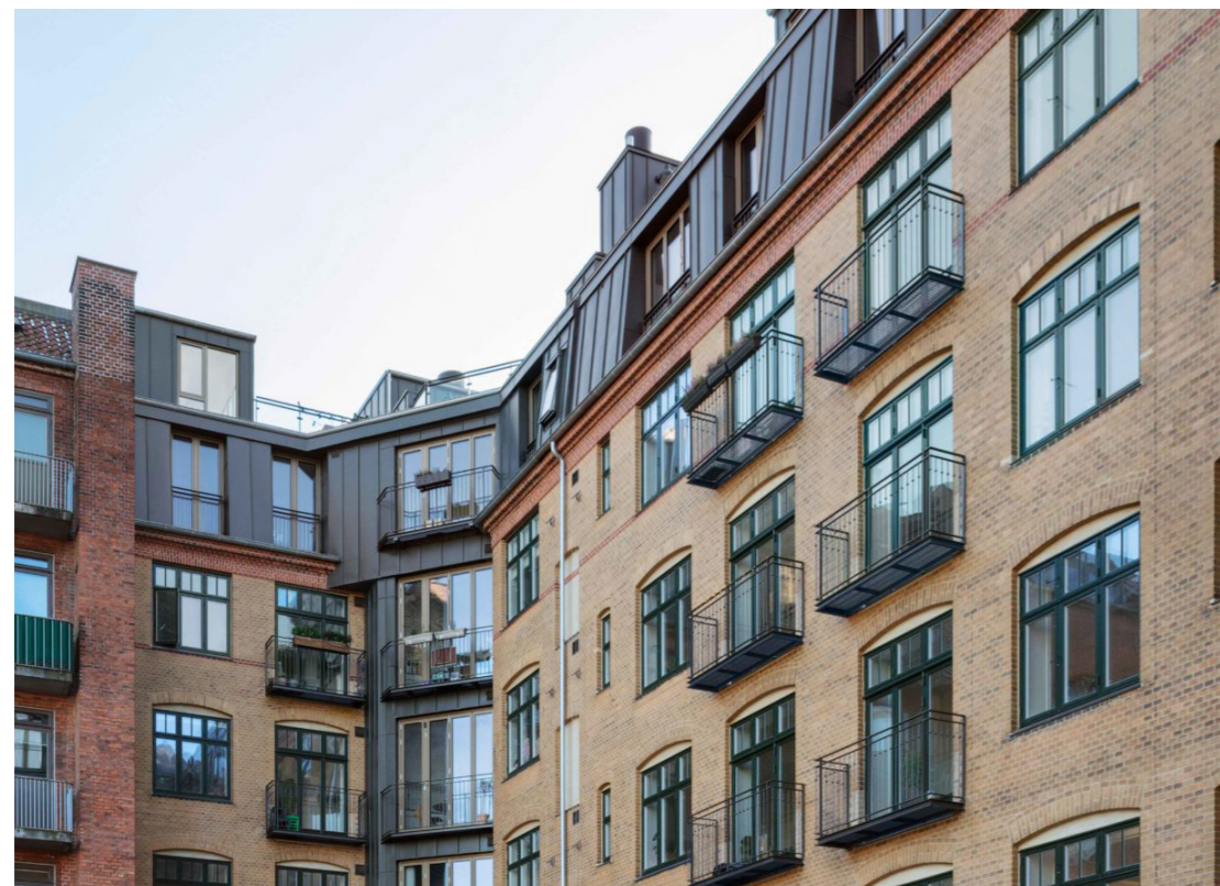
Ryesgade 25 med ny tagetage og udbygning til køkken.
