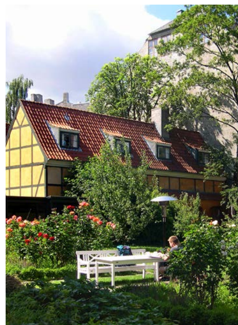
Herunder ser man fra Valkendorf-kollegiets baghave over mod de gamle bindingsværksslænger bag Teglgårdstræde 12 (11). Se mere om Valkendorfs Kollegium i Grønne lunger pp. 22-23 samt i eksempelsamlingen på www.jenshvass.com .
