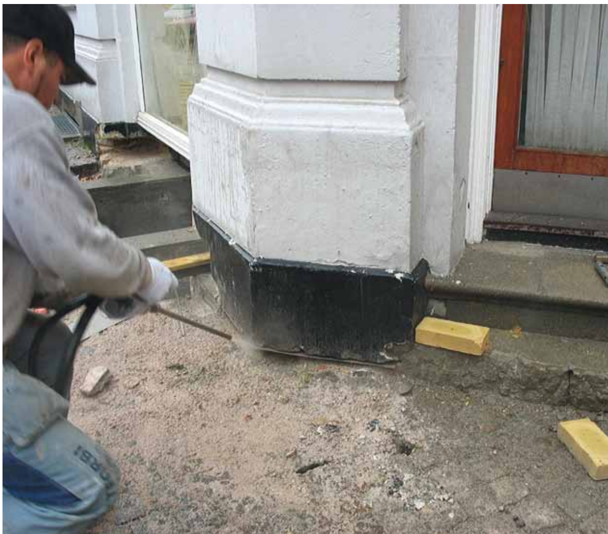
Sprøjteudfyldning af spalte
