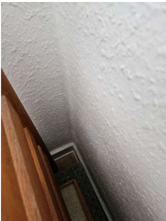
Indeklimaet virkede tørt, vinduet stod åbent. Der var ingen tegn på skimmel, heller ikke bag møbler i de koldeste hjørner, her mod den uisolerede facade.
