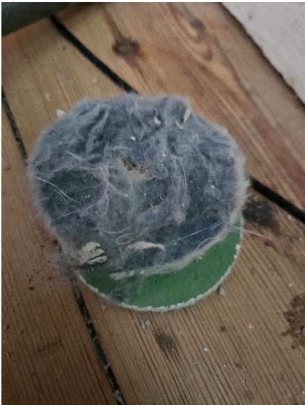
Isolering efter udtagning fra væggen.
