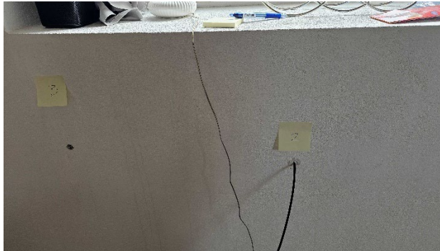
Der blev ikke observeret nogen skader eller kritiske forhold ved den efterisolerede væg.
