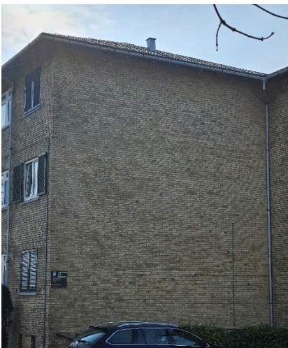
Udvendigt ser murværket fint ud. Muren vender mod nord.
