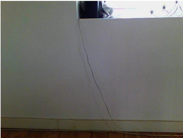
Termografien afslørede et koldt område ved brystningen, hvor der enten mangler isolering eller muren er utæt for vindpåvirkning.
