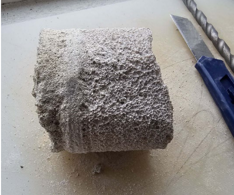
Det inderste af en borekerne, som viser, fra venstre, mursten, puds, limmørtel og isolering. Materialerne vedhæftning er god
