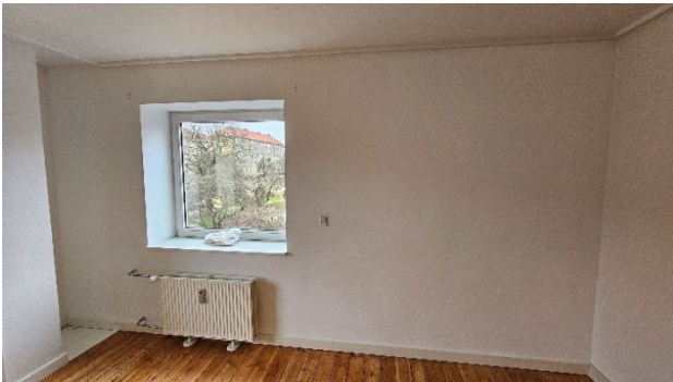
Lejligheden var fraflyttet. Der blev ikke observeret nogen skader eller kritiske forhold ved den efterisolerede væg. Der havde været en gardinstang, tilsyneladende uden problemer.
