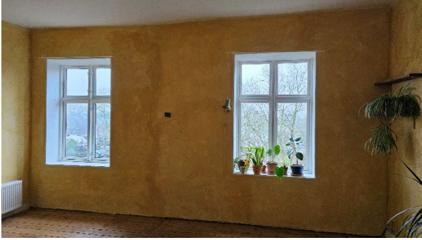
Fraflyttet værelset med mange planter. Den sorte afmærkning viser, hvor korttidsmåling af RF og T med Rotronic blev monteret. Borekernen blev taget ud tæt på dette sted.
