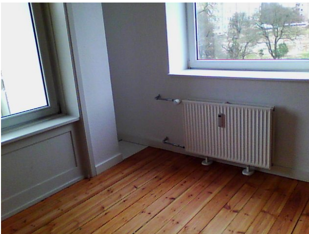
Varmerør til radiator var skjult inde i isoleringen.
