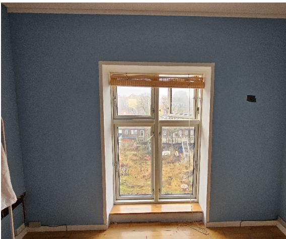
Overfladen af de efterisolerede vægge var helt uden skader. Den sorte afmærkning viser, hvor korttidsmåling af RF og T med Rotronic blev monteret. Borekernen blev taget ud lidt under dette sted.
