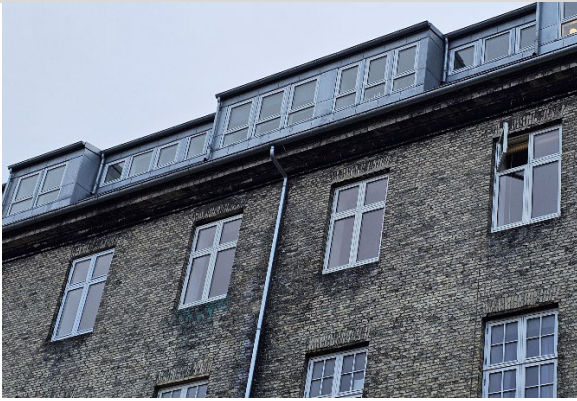
Facaden mod nordvest. Murværket så meget oprindeligt ud, men sten og mørtelfuger virkede rimeligt intakte.
