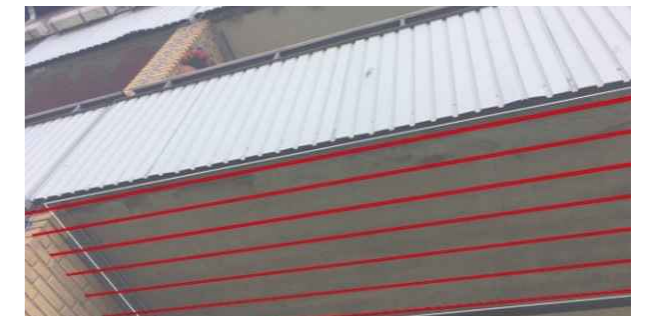
Figur 19 Altanplader understøttet af tværvægge. Øverst: Tværvægge udført i beton med gennemgående altanplade som er sammenhængende i hele bygningens længde. Nederst: Tværvægge udført i murværk. Altanplader er ikke gennemgående. Den bærende hovedarmerings orientering i altanpladerne er indtegnet.
