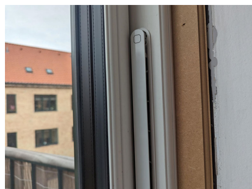
Fig. 1 En spalteventil integreret i nyinstalleret altandør
