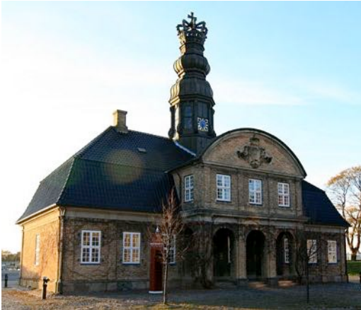
Barokken kan kendes på de svungne former og huskroppens tyngde. Taget er et todelt mansardtag.
