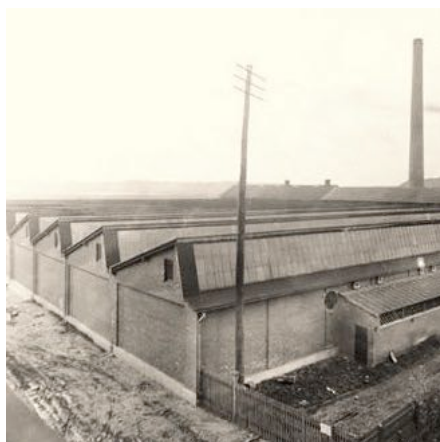
Tv: Shedtage med glas i den stejle del. Tagformen var meget brugt i industribyggeri i slutningen af 1800-tallet.
