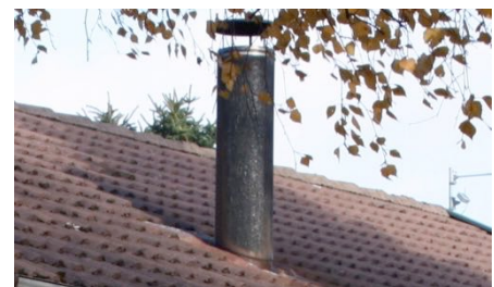
I 1970'erne oplagdes en del cementtagsten på parcelhuse – som et billigere alternativ til tegl.
