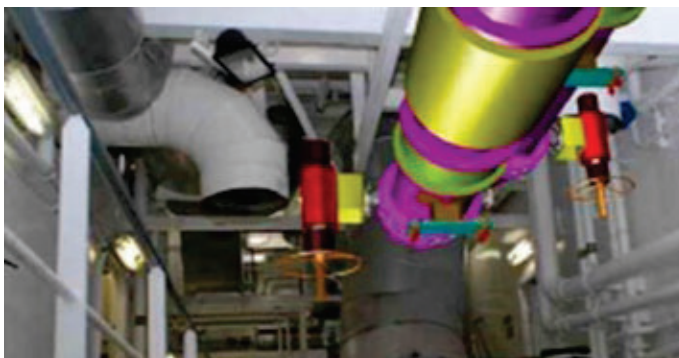
FIGUR 38. Augmented Reality (AR) indlagt som 3D-model i den eksisterende VVS-installation. Kilde Kjeld Svidt, AAU BUILD i Aalborg.
