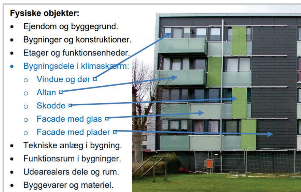
FIGUR 8. Eksempel på forskellig bygningsdele i facaderenovering på almen bebyggelse på Amager, som til venstre er indsat i kæden for fysiske skalatrin. Kilde [Bertelsen et al., 2022, side 35]
