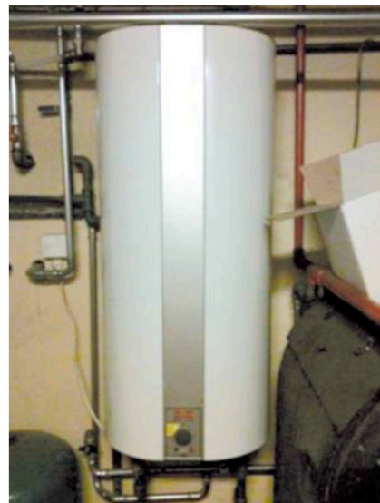
Figur 4. Nyere beholder med varmespiral
