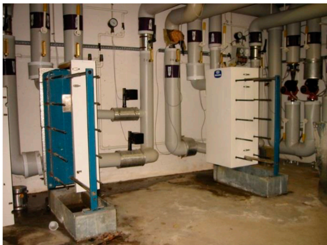
Figur 3. Indirekte anlæg med veksler i etagebolig
