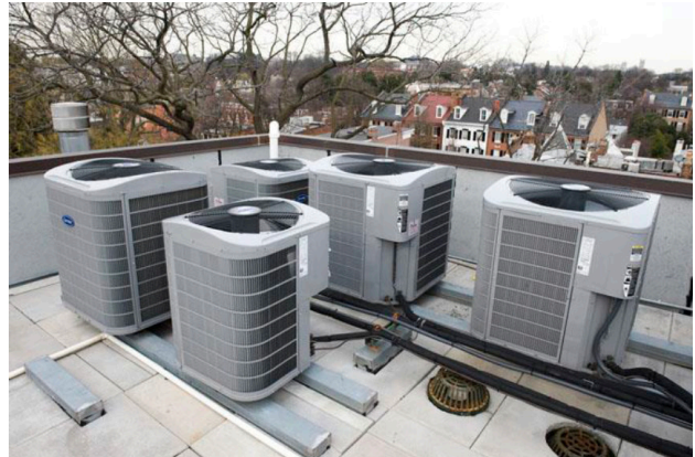
Figur 3. Kondensatorer (luftkølede)
