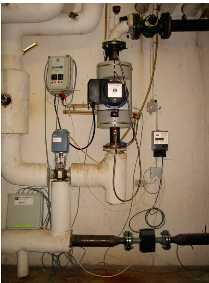
Figur 3. Præfabrikeret isoleringskappe på cirkulationspumpe
