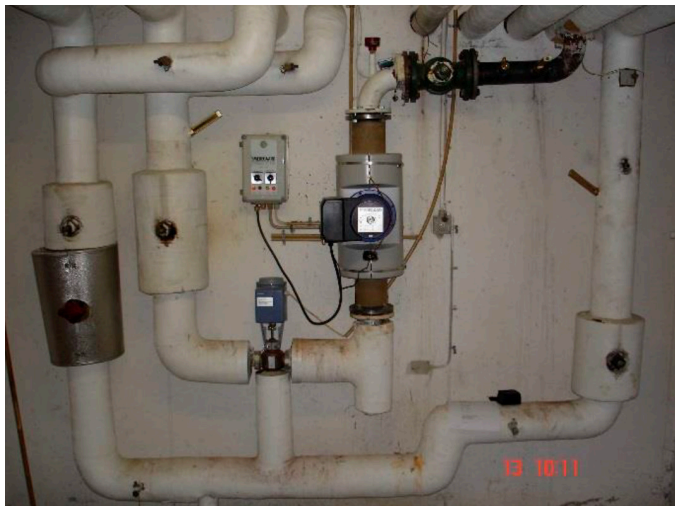
Figur 1. Direkte anlæg med blandesløjfe i etagebolig
