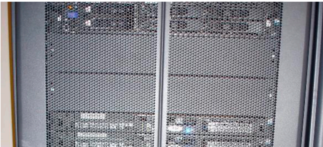
Figur 14. Indførelse af blændplader på tomme pladser i rackene
