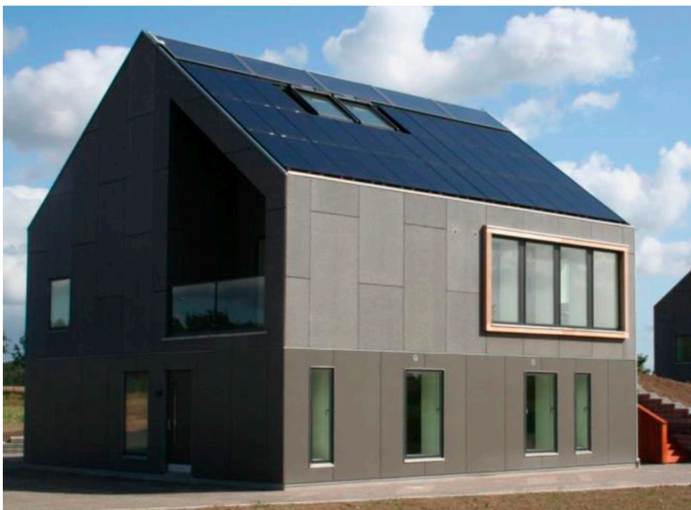
Figur 1. Solceller på tagflade. Foto: Teknologisk Institut
