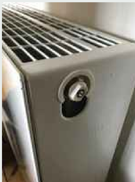
Figur 3 - Udluftningsventil
