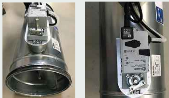
Figur 1 – Trykstyret motor på reguleringsspjæld, til fx VAV-zonestyring
