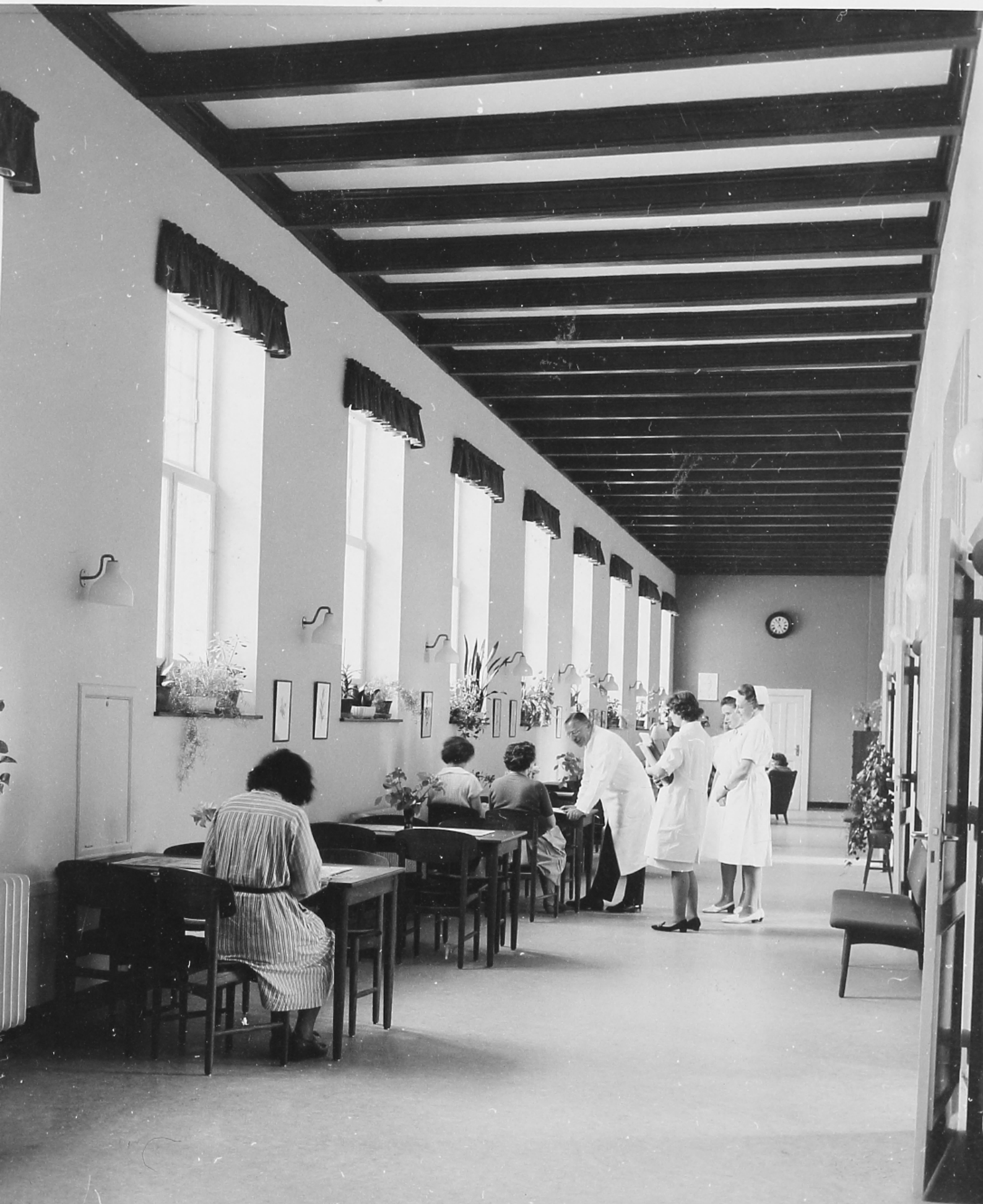
Billede 9. Kurhusets Bygning 21, ca 1966. De bærende bjælker i trædækket over gangen er synlige, og man ønsker at bevare dette udtryk efter renoveringen.
