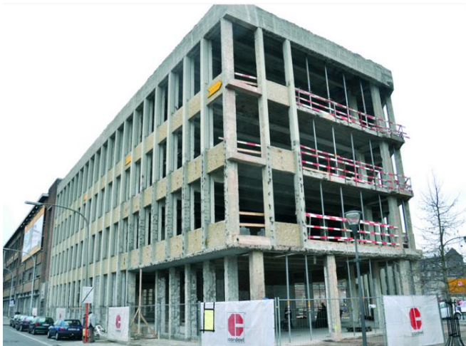
Ejendommen under transformation (Foto: Grontmij).
