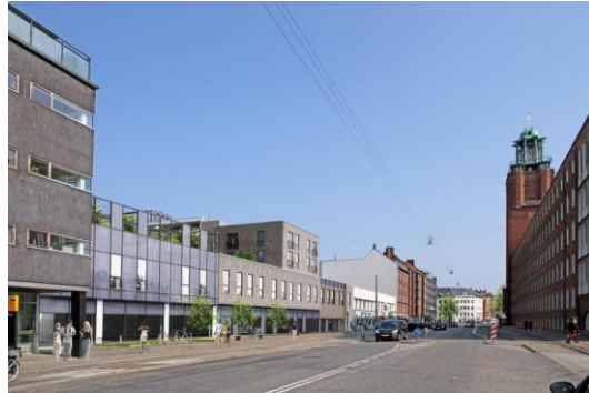
Figur 9. Smallegade 14-18, Frederiksberg, er under transformation med henblik på udlejning til blanding af detailhandel, erhverv og ungdomsboliger. Bygningen blev opført i starten af 1960'erne og fremstod nedslidt. Råhuset derimod var i god stand og er blevet genanvendt i sin helhed. Developeren Green Estate overvejede ikke nedrivning, grundet den velfungerende parkeringskælder, som ligger under ejendommen og naboet. Samtidig er råhuset opført i jernbeton støbt på stedet, hvilket vil være vanskeligt og dyrt at rive ned og nedknuse. Kommunen tillod ikke, at der blev lagt etager til, da det ville tage lys fra et lejlighedskompleks på Howitzvej, som ligger bag ejendommen. (Foto og rendering: Sahl Arkitekter)
