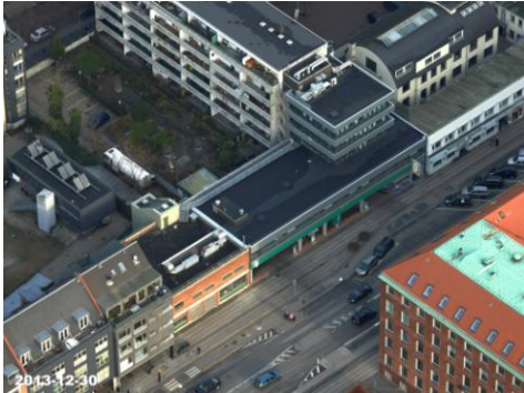
Figur 9. Smallegade 14-18, Frederiksberg, er under transformation med henblik på udlejning til blanding af detailhandel, erhverv og ungdomsboliger. Bygningen blev opført i starten af 1960'erne og fremstod nedslidt. Råhuset derimod var i god stand og er blevet genanvendt i sin helhed. Developeren Green Estate overvejede ikke nedrivning, grundet den velfungerende parkeringskælder, som ligger under ejendommen og naboet. Samtidig er råhuset opført i jernbeton støbt på stedet, hvilket vil være vanskeligt og dyrt at rive ned og nedknuse. Kommunen tillod ikke, at der blev lagt etager til, da det ville tage lys fra et lejlighedskompleks på Howitzvej, som ligger bag ejendommen. (Foto og rendering: Sahl Arkitekter)
