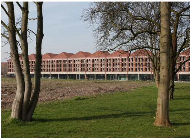
Tørreskurene efter transformation (Foto: Lens-Ass Architects).
