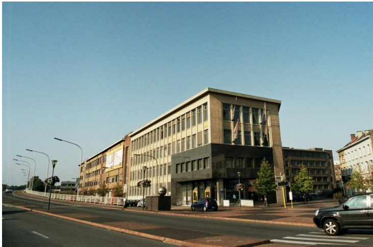
Ejendommen inden transformation (Foto: Grontmij).
