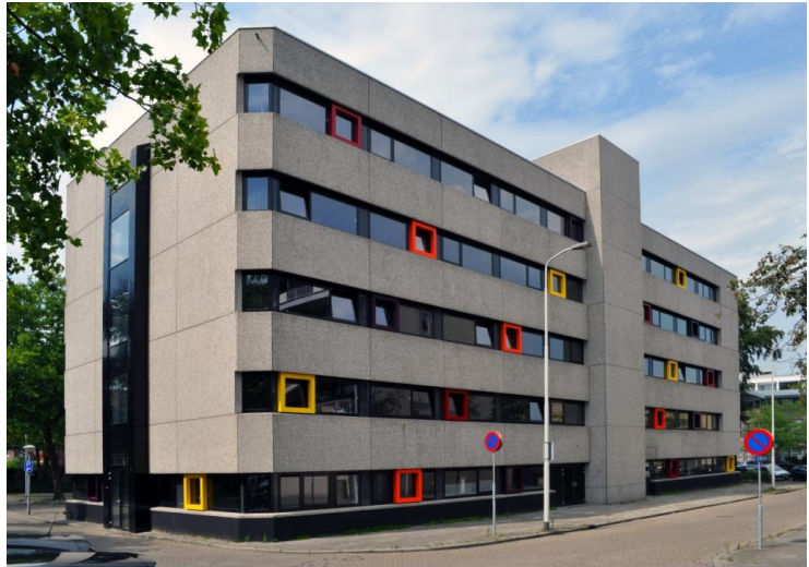
Ejendommen efter transformationen (Foto: Vissers & Roelands).
