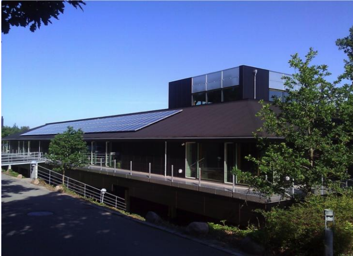
Rockwool International efter renovering (Foto: Rockwool International).
