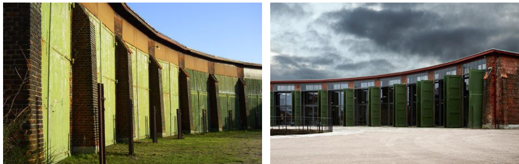
Figur 7. Lokomotivremisen i Brande blev i 2005-07 transformeret fra at være en rest fra fortiden til et omdrejningspunkt for byudvikling. Bygningen huser i dag teatersal samt udstillings- og conferencefaciliteter. Toiletterne er indrettet i den gamle smøregrav, og baren i caféen står på originale skinner - så den kan rulles uden for om sommeren - hvormed bygningens oprindelige funktion er trukket op til nutiden. Transformationen kom i stand ved et offentligt-privat samarbejde mellem Brande Kommune, en række fonde, private sponsorer og Foreningen Kulturremisen. (Foto: Jørgen Overbys Tegnestue)
