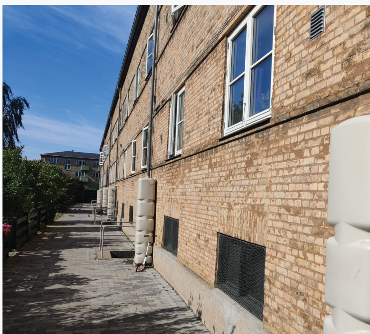
Figur 06. Vendsysselvej 3-37 i Vanløse er en afdeling under KAB og rummer 89 boliger. I afdelingen, der har SAVE-kategori 4, er der siden 2014 gennemført en række bæredygtighedstiltag, herunder opsætning af solceller, regnvandsopsamling, nye vinduer, isolering af skunk og etableret nyt vaskeri, der udnytter det opsamlede regnvand. Ejendommen har ikke et energimærke. Solcellerne dækker 90% af det fælles elforbrug i afdelingen, men kan ikke ses fra gaden. Facaden mod gaden er relativt uberørt af tiltagene, mens beholderne til opsamling af regnvand sætter et visuelt præg på facaden i gården. Fotos: Forfatterne.
