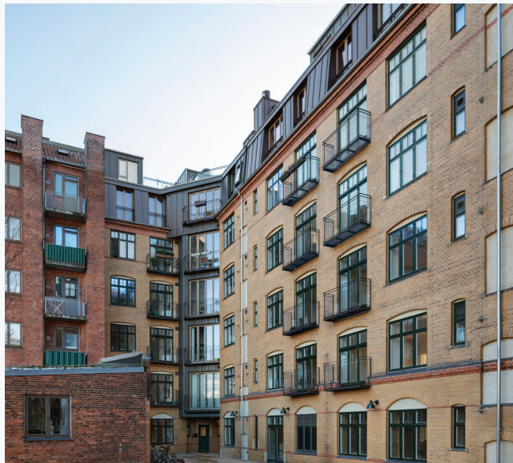
Figur 07. Rymsgade 25 i København er et eksempel på en gennemgribende energirenovering af en ældre bevaringsværdig beboelsesejendom. Ejendommen ejes af Drost-fonden. Der er ved renoveringen gennemført indvendig efterisolering af facade med højsolerende skum (50 mm, svarer til 100 mm mineraluld), udvendig efterisolering af gavl, tagisolering og etablering af solceller på taget, nye vinduer, nyt to-strengs varmeanlæg med ny automatik, decentrale ventilationsanlæg i lejligheder med 85% varmegenvinding og behovsstyret ventilation, der kan overstyres. Herudover er ejendommen blevet DGNB-certificeret. Der er gennemført commissioning af projektet. Der er etableret et anlæg til lokal afledning af regnvand (LAR) med et filterbed til tagvandet inden vandet løber i faskinen. Ejendomme har SAVE-værdi 4 og energimærke B, hvilket er usædvanligt (gælder kun 1% af alle bevaringsværdige ejendomme). Fotos: Krydsrum Arkitekter
