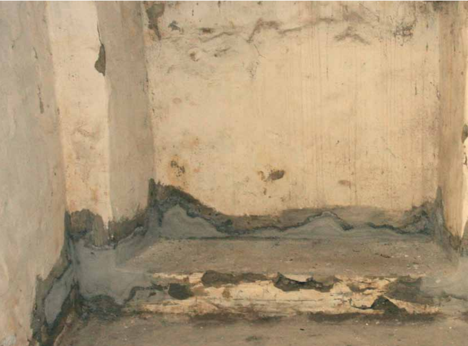
Fundamentsforstærkning udført i kælderydervæg
