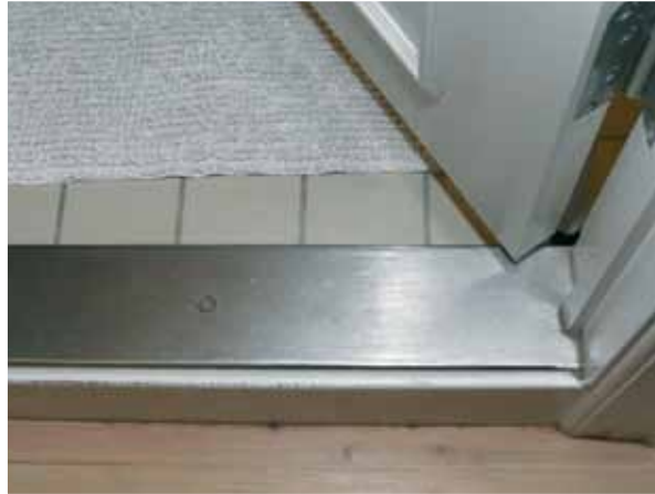
Dørtrin til toilet og bad. En godt sikret løsning
