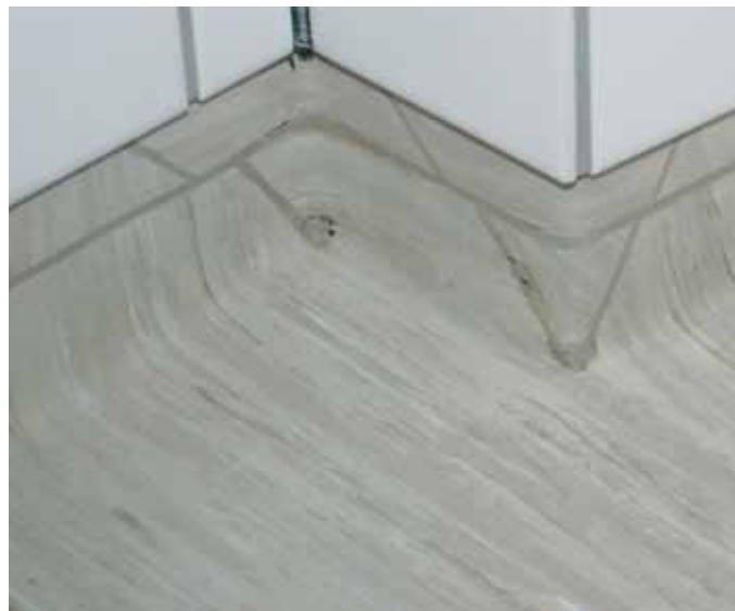
Vinylbelægning på gulv
