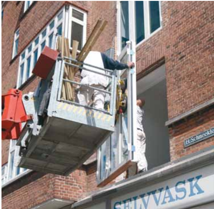
Udskiftning af vindue
