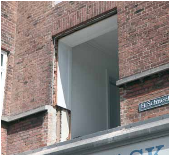
Udskiftning af vindue
