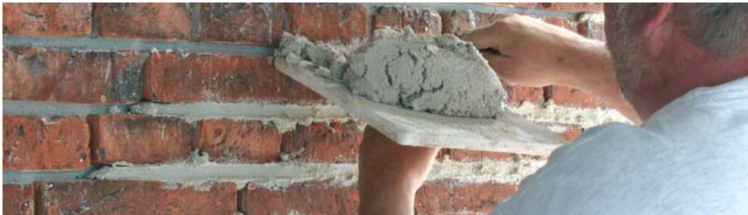
Mureren laver skrabefuger
