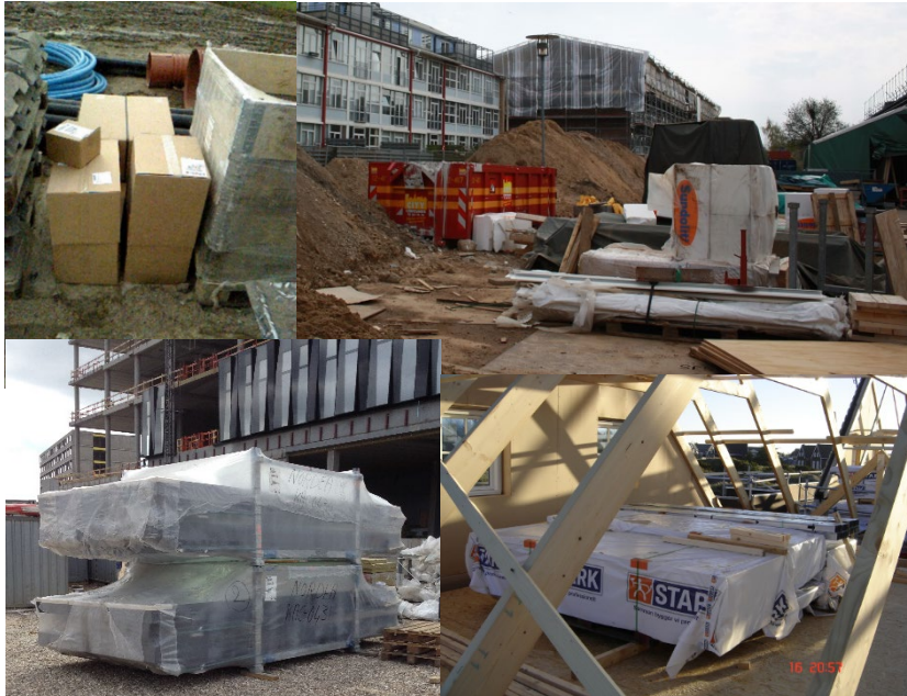
FIGUR 22. Forskellig pakning og levering på byggepladsen. Øverste billede til venstre viser pakker, som er leveret i mudret på byggepladsen. Øverste billede til højre viser levering på byggepladsen, som senere skal fordeles på bygningerne. Nederste billede til venstre viser færdige facadeelementer, pakket og mærket klar til montering af Scheldebouw i Holland. Nederste billede til højre viser pakker med indvendig beklædning leveret direkte på tagetage.
