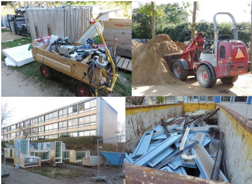
FIGUR 18. Eksempler på flytbare lagerområder på byggepladsen ved renovering af almen boligbebyggelse i Aarhus. I øverste venstre billede er vist værktøjsvogn, som flyttes mellem lejlighederne. I øverste højre billede er vist lager af grus. I nederste venstre billede er vist et åbent lager med indpakkede vinduer og døre. I nederste højre billede er vist container til sorteret affald.
