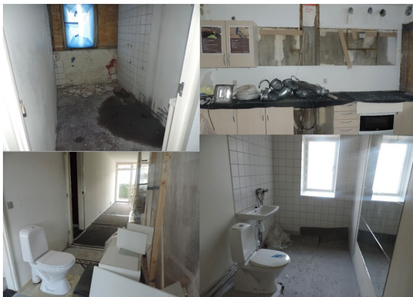
FIGUR 15. Eksempel på arbejdsområder i tilknytning til renovering af badeværelse og faldstammer i almen bebyggelse i Aarhus. Øverste billede til venstre er det afriggede gamle badeværelse med reparation af betongulv. Øverste billede til højre er køkkenet med nedtagede overskabe, så der er adgang til installationerne. Nederste billede til venstre er lagerpladsen i stuen. Nederste billede til højre er det færdige badeværelse.
