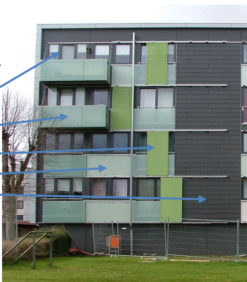
FIGUR 12. Anvendelse af gentagelser på forskellige lokationer i byggelogistik er her vist på en renovering af facader på 4 almene boligbebyggelser på Amager. Et facadeudafsnit for en opgang med 4 etager på havesiden er valgt som gentagende enhed, der udføres af samme byggesjak, og som gentages på i alt 132 facadeudsnit med et taktslag på 3½ dage [Bertelsen, 2010].
