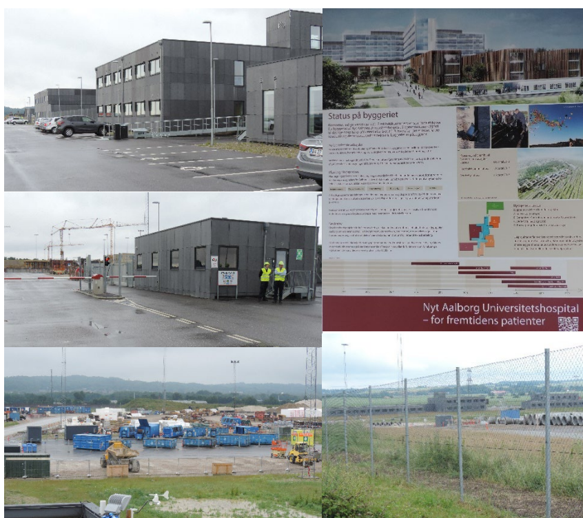
FIGUR 19. Eksempler på indretning af fælles funktioner ved bygning af Nyt Aalborg Universitetshospital (NAU) i Aalborg Øst. I øverste venstre billede er vist fælles kontorer og møderum. I midterste venstre billede er vist portindgang til byggepladsen. I øverste højre billede er vist fælles skiltning. I nederste venstre billede er vist fælles lagerområde. I nederste højre billede er vist indhegning, som lukker hele byggepladsen af, og hvor der er døgnvagt på.
