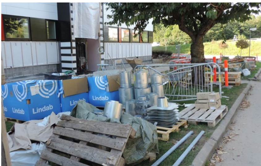
FIGUR 13. Indgangsfacade ved renovering af facader, badeværelser, faldstammer og udearealer i almen bebyggelse i Aarhus med 10 boligblokke på 4 etager. Her er hver indgang valgt som gentagelsesenhed for hver af de aktuelle bygningsdele, hvorfor bygningsdelslagret ligger udenfor hvert indgang.
