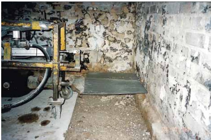
Indvibrering af stålplader
