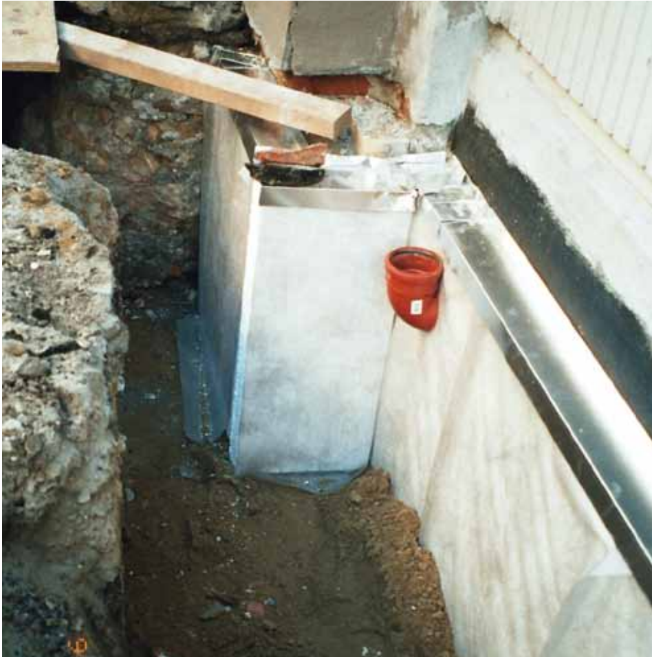
Udvendig fugtisolering
